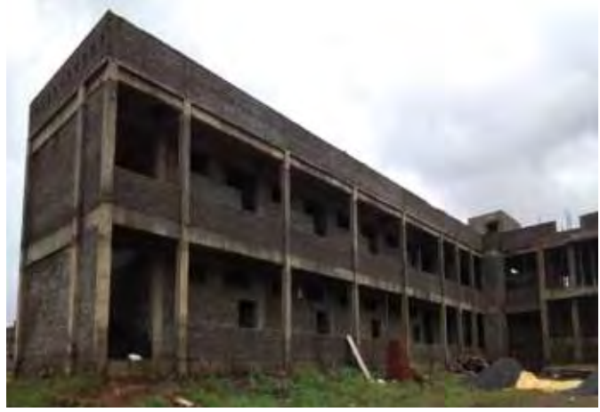
स्कूल भवन सी विंग, ईएमआरएस-दहानू
