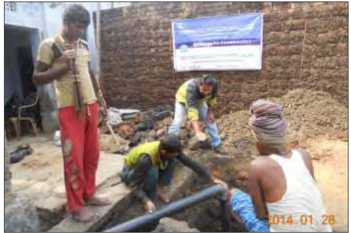
बिहार, नालंदा में सोकेज पिट्स का निर्माण
