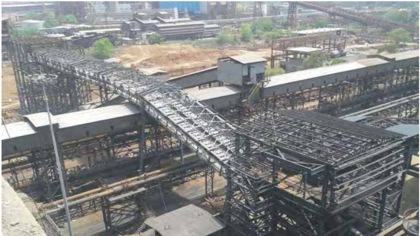
भिलाई स्टील प्लांट में कार्य प्रगति पर, भिलाई
