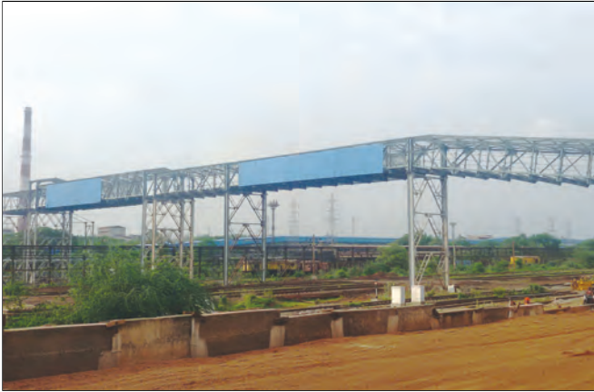
भिलाई इस्पात संयंत्र परियोजना-रेल लाइन पर कन्वेयर गैलरी का निमाण
