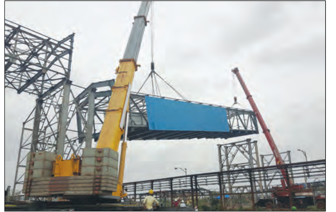
भिलाई इस्पात संयंत्र परियोजना-रेल लाइन पर कन्वेयर गैलरी का निमाण
